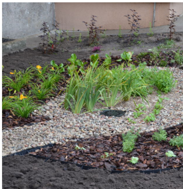
Ogród deszczowy uszczelniony folią położony przy budynku w Zaulku Optymistów w Olsztynie. Realizacja Fundacja Sendzimira. Fot. Urząd Miasta Olsztyna
