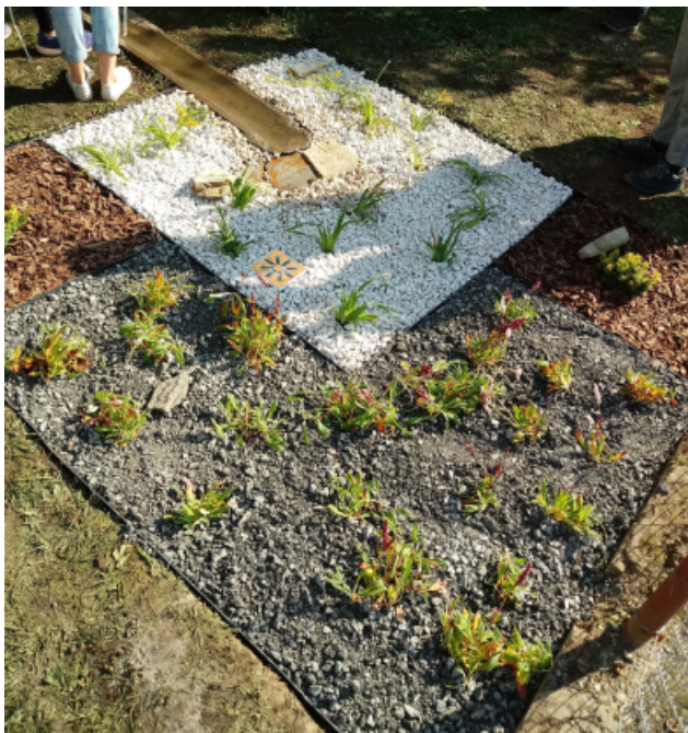
Ogród deszczowy infiltrujący wodę do gruntu w Jarosławiu. Realizacja Fundacja Sendzimira
