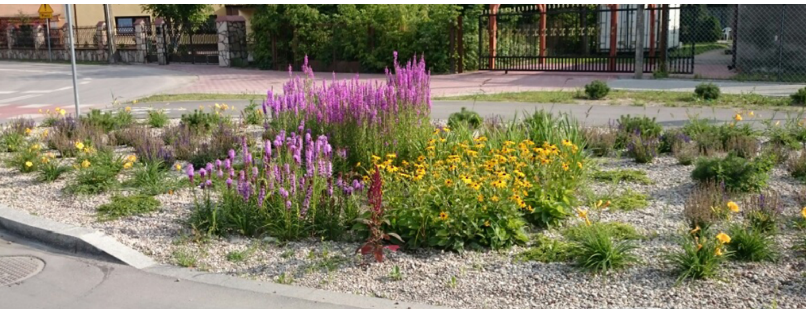
Rondo infiltrujące w Markach – przykład ogrodu deszczowego oczyszczającego wodę z pobliskich dróg, chodnika i ścieżki rowerowej. Realizacja Fundacja Sendzimira
