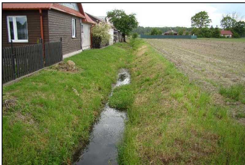
Fot. 13 Dopływ spod Stasiówki, widok w kierunku południowym, rów w dobrym stanie
